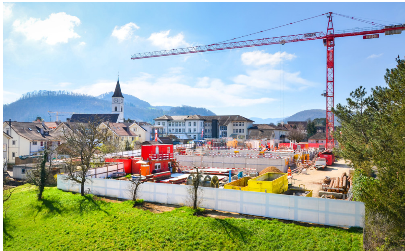
Mit dem Bau der Dreifachsporthalle geht es zügig voran.
