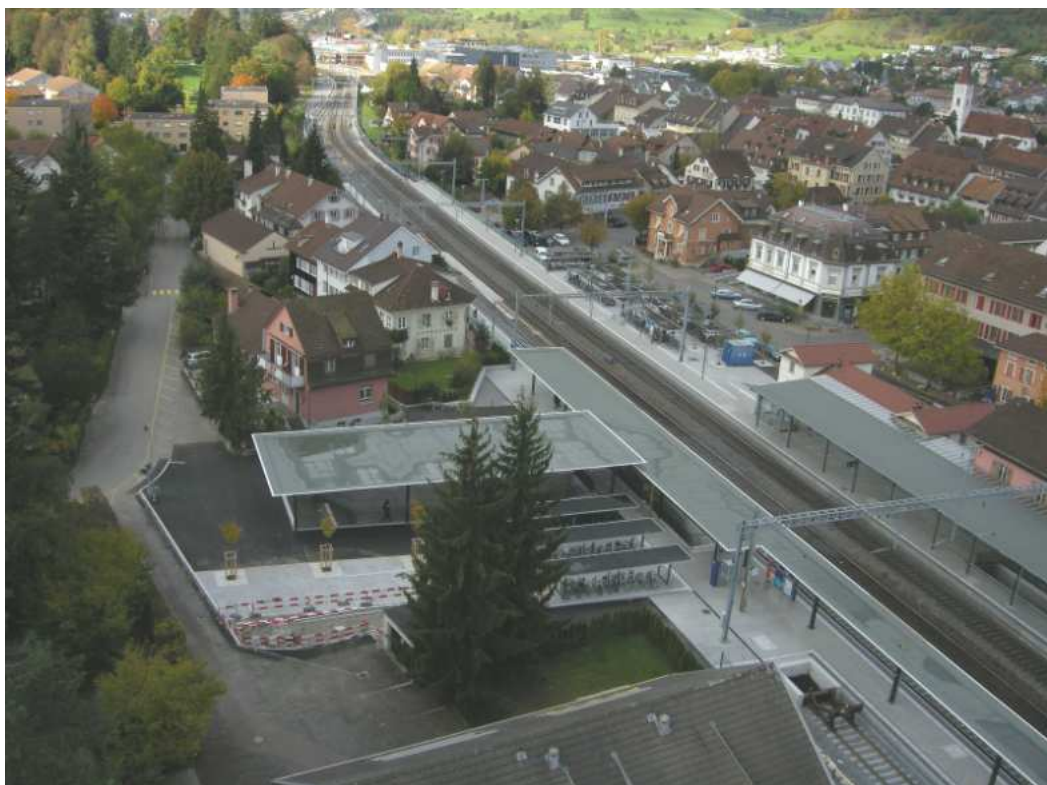
2007, Blick auf Standort Terminus ohne Unterführung nach Umbau Bahnhof
