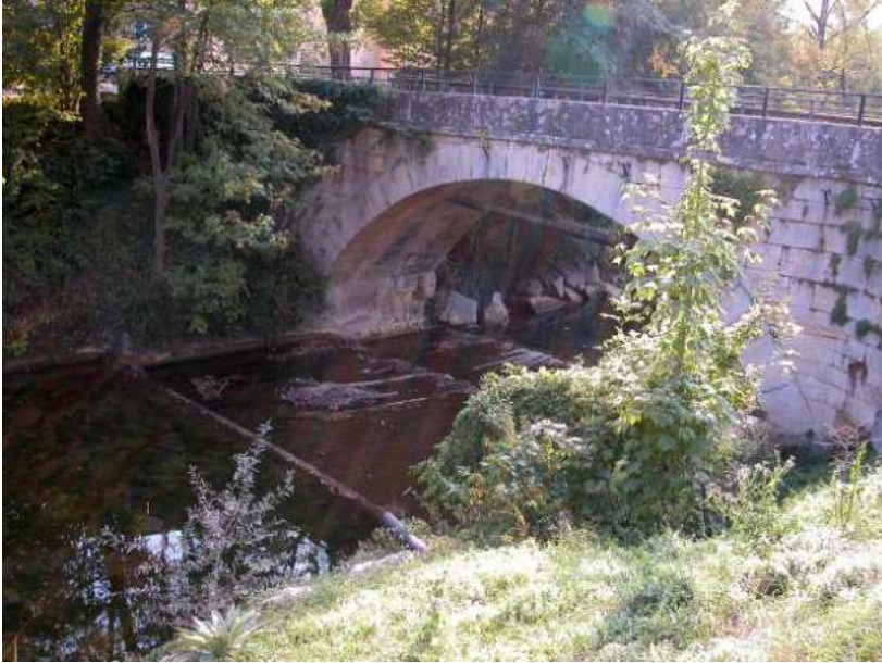
2003, vor Restaurierung / Fundamentarbeiten
