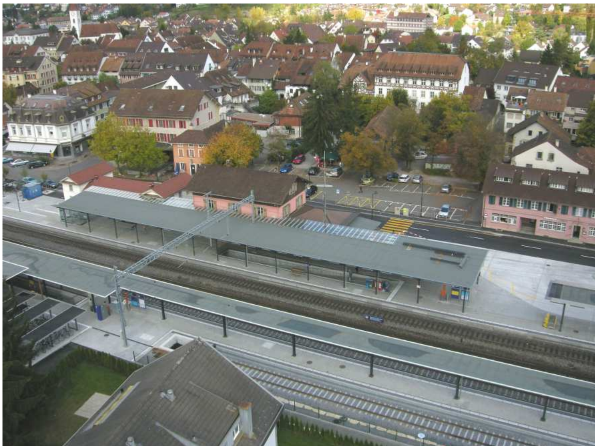
2007, Standort ehemalige Unterführung, nach Umbau Bahnhof/ Busbahnhof
