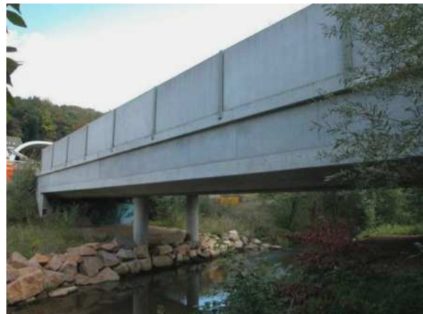
Brücke und Tunnelleinfahrt Ergolz West
