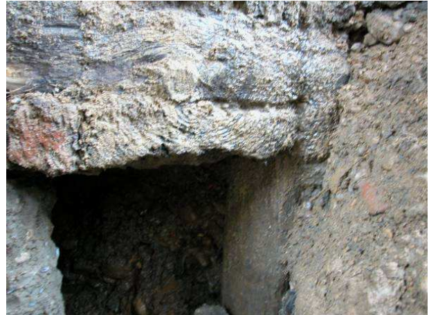
Blick auf die freigelegten Eichenbalken, auf welchen das Brückenfundament auflag.
