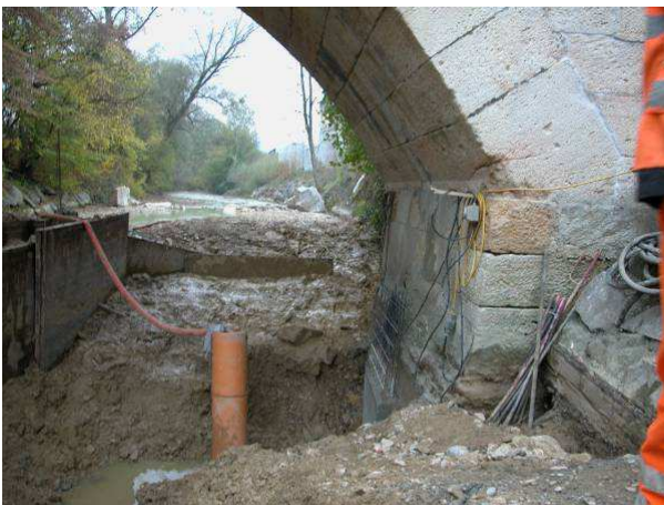
Blick auf die freigelegten Eichenbalken, auf welchen das Brückenfundament auflag.
