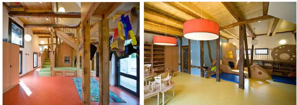
Abb. 25: Beispielbilder für Variante 4, Fachwerksanierung einer Scheune zu einer Kindertagesstätte in Sehnde bei Hannover, Architekturbüro Michelmann (Quelle: www.holzbau-burgwedel.de)
