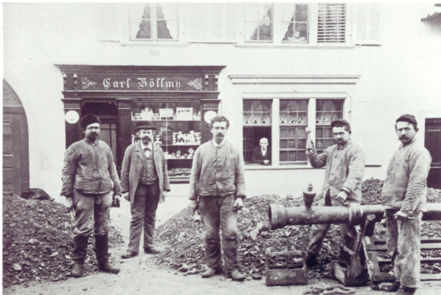
Installateure sind anno 1898 dabei, Leitungen für die erste gemeindeeigene Wasserversorgung zu verlegen. Dieses Bild entstand vor der Hauptstrasse 70 und stammt aus dem Buch «Alt Sissach».
