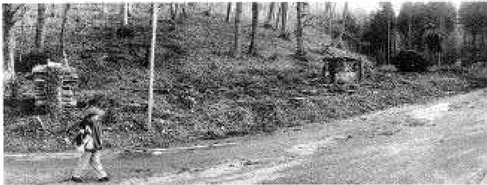
Blick aufs Reusli, wo für den neuen Weiher bereits erste Vorbereitungsarbeiten vorgenommen worden sind.
