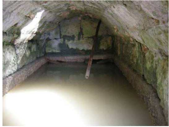
Gewölbe mit 2 zuführenden Akten Bereich Wasserspiegel sowie Eisenrohrzuführung (diese s.w. von 1916) 2009
