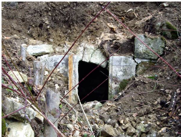
Vormauerung z.T. weg, Wurzelstoch sichtbar
