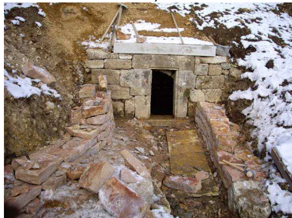
Trockenmauerbau auf Seiten
